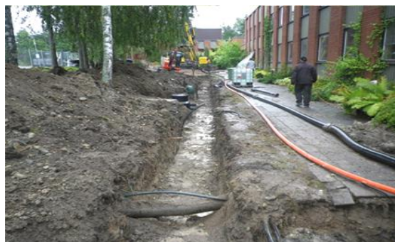
Ihopkoppling av slangar
